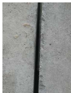
Figura 13. Juntas verticais.
