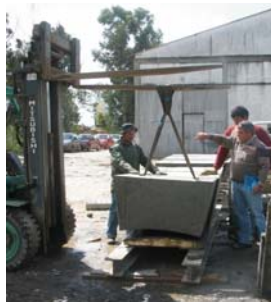
Figura 11. Descofragem com empilhadora
