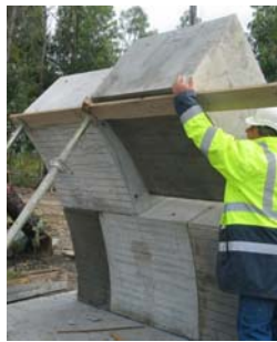
Figura 17. Suporte de aduelas em escoras.
