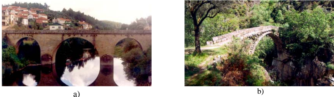
Figura 1. Duas pontes em Portugal: a) ponte romana sobre o rio Alva, Arganil; b) ponte do diabo, Misarela.
