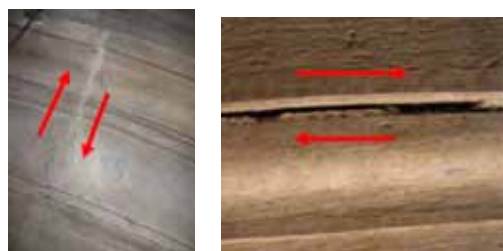
Fig 6 – Escorregamento entre pedras do arco
