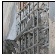
Figura 13. Reparação do betão e reforço das armaduras
