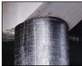
Figura 12. Reforço de pilares com CRP
