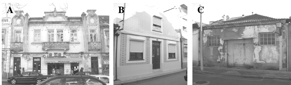
Figura 1: Exemplos de edifícios estudados: tipologias A, B e C.
