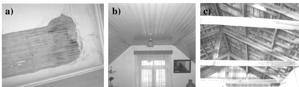
Figura 2: Tectos e cobertura: a) estuque sobre fasquiado; b) forro de madeira; e c) estrutura de cobertura.
