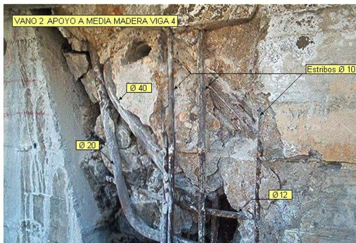
**Vista de una cala realizada para determinar una configuración de armado y la pérdida de sección de las armaduras**
