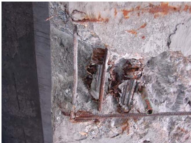
Obsérvese el inicio de los procesos de corrosión en la armadura activa
