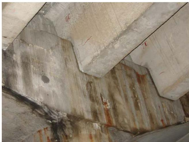
**Pilas y cargaderos con escurrimientos a través de las juntas de dilatación del tablero
