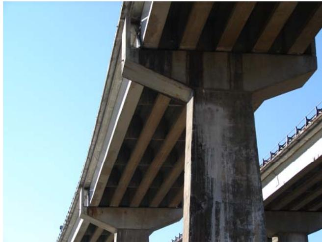
Vista del aspecto que presenta un viaducto con defectos de corrosión de las armaduras
