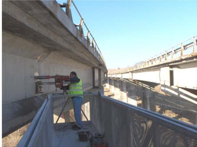
Vista de los trabajos de extracción de testigos de un viaducto
