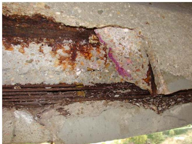
Obsérvese la rotura de los alambres de pretensado por corrosión
