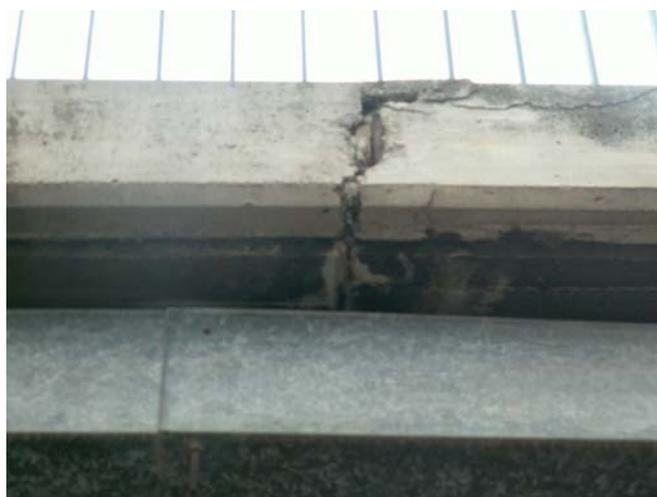
**Deterioro de una junta de dilatación, propiciando el escurrimiento del agua a través de la misma
