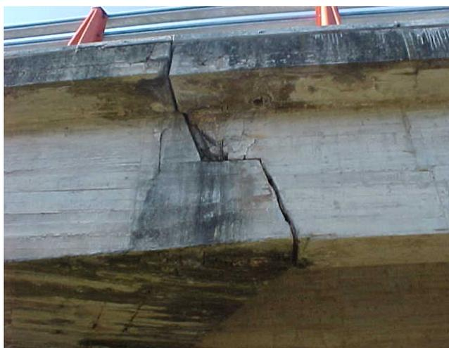
**Deterioro de una junta de dilatación de un apoyo a *media madera*, propiciando el escurrimiento del agua
