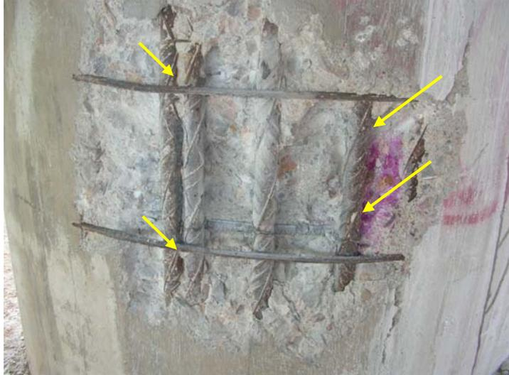
Inicio de la corrosión de las armaduras por carbonatación del hormigón de recubrimiento
