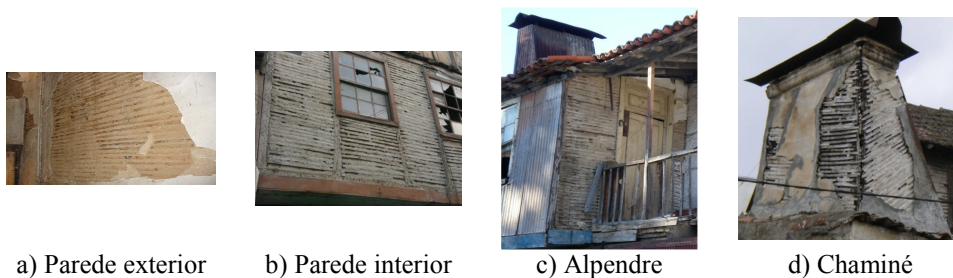
Figura 2 – Elementos construtivos de tabique
