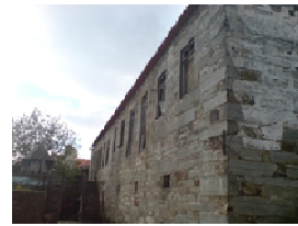
f) Construção Nº 6
