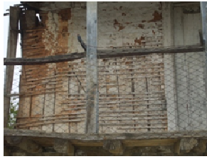
a) Construção Nº 1
