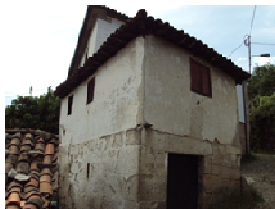
j) Construção Nº 10
