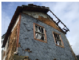
g) Construção Nº 7
