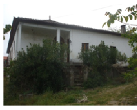
b) Construção Nº 2
