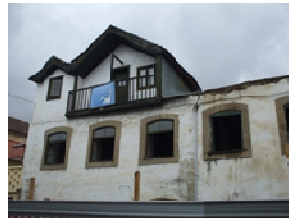
h) Construção Nº 8
