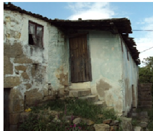
k) Construção Nº 11
