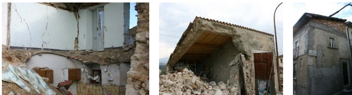
Figura 20: Métodos construtivos: a) utilização de arcos como elementos estruturais de pisos inferiores; b) e c) presença de vigas de coroamento em betão armado
