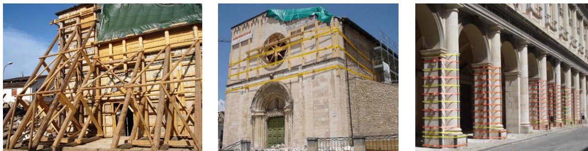
Figura 3: Procedimentos de consolidação temporária
