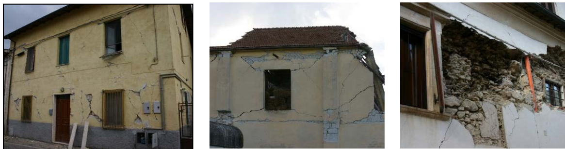
Figura 23: comportamento no plano de paredes de alvenaria
