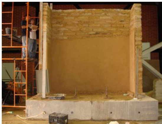
Figura 5: Construção da parede de adobe (aplicação do reboco)
