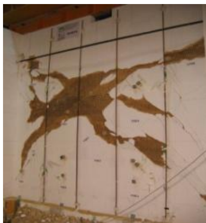
Figura 7: Estado final de danos
