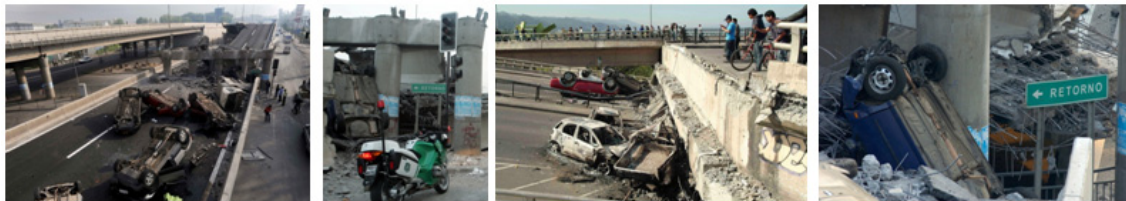
Figura 1. Danos ocorridos em pontes de betão armado, no sismo do Chile de 2010 (adaptada de REUTERS, 2010).
