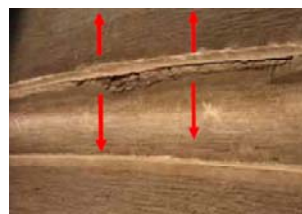
Fig 4 – Abertura de junta entre o arco de intradorso e de extradorso
