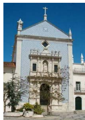
Fig 1 - Alçado principal da Igreja da Misericórdia de Aveiro
