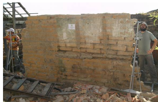
Fig. 12 – Parede ensaiada in-situ .
