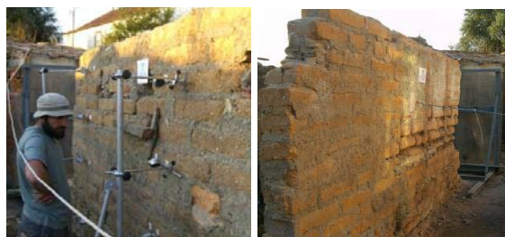
Fig. 18 – Ensaio da parede in-situ fora do plano: transdutores e aplicação da força horizontal.
