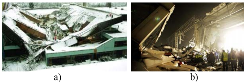
Figura 2 – Colapso de coberturas: a) ringue de patinagem na Baviera, Alemanha; b) centro de exposições em Katowice, Polónia (BBC News).
