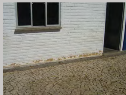
Figura 5 - Exemplo de construções em BTC
