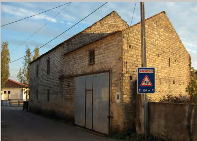
Figura 3 - Exemplos de construções em alvenaria de adobe
