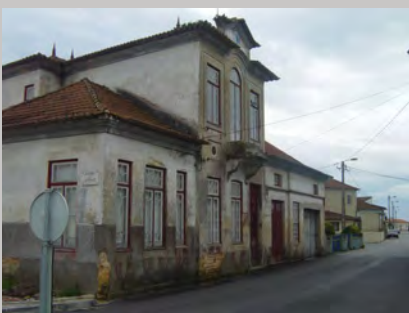
Figura 3 - Exemplos de construções em alvenaria de adobe
