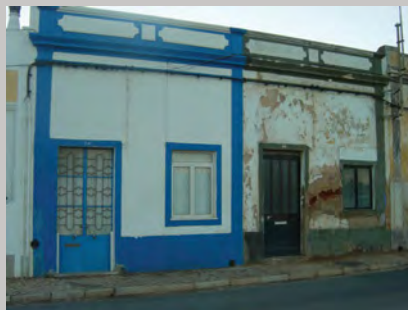
Figura 4 - Exemplo de construção em Taipa
