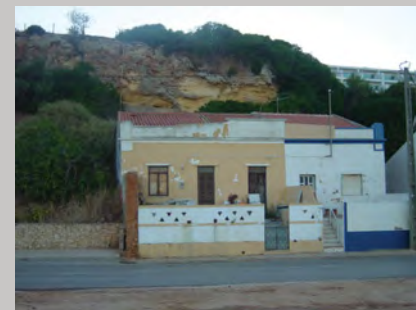
Figura 4 - Exemplo de construção em Taipa
