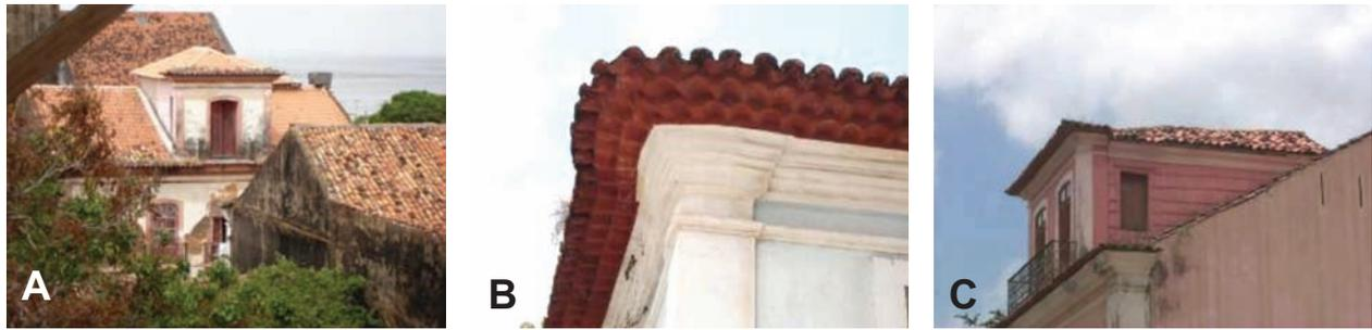
**Figure 9.** Cobertura: (a) cobertura com mirante, (b) beiral arrematado por cimalha, (c) mirante com lateral revestida de telha cerâmica.
