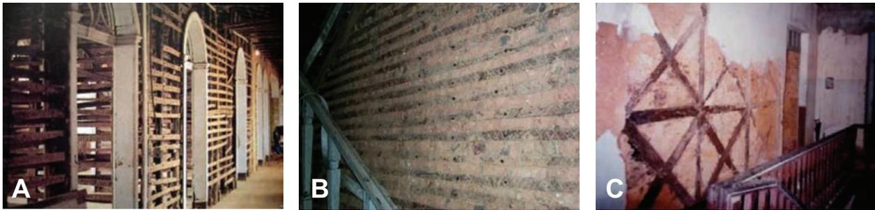
**Figura 6.** Alvenarias internas: (a) armação de pau-a-pique e varas, (b) alvenaria em tabique, (c) alvenaria com armação em cruz de Santo André.
