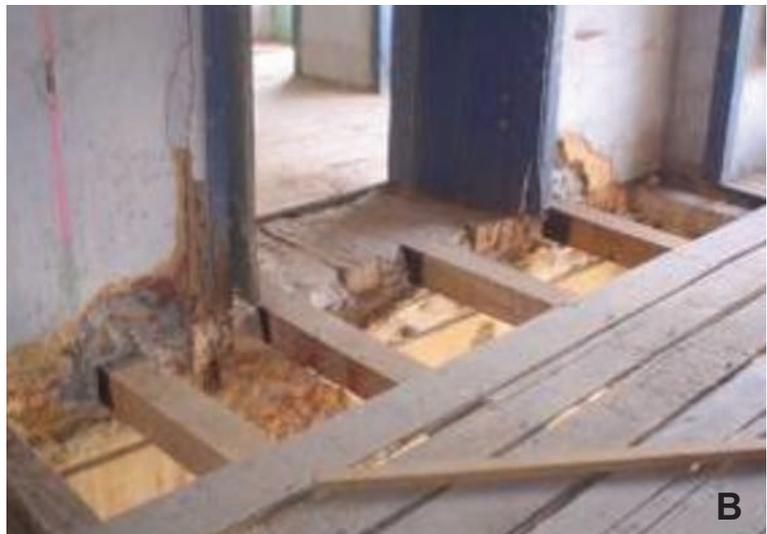
**Figura 4.** (a) Trecho de parede de prédio da Baixa Pombalina, com travamento dos pisos e o encaixe com a parede interna do sistema de gaiola. (b) Prédio do centro histórico de São Luís apresentando apenas o travamento dos pisos feito com grandes barrotes de madeira (suporte para o assoalho) engastados na parede.
