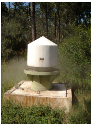
Fig.1- “Chaminé” existente ao longo do exutor submarino da Fábrica de Pasta de Papel, na Mata Nacional do Urso.
