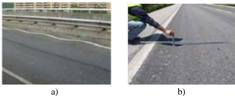
Figura 2.5 - a) Ondulação; b) Rodeiras de raio pequeno (Alves, 2007)
