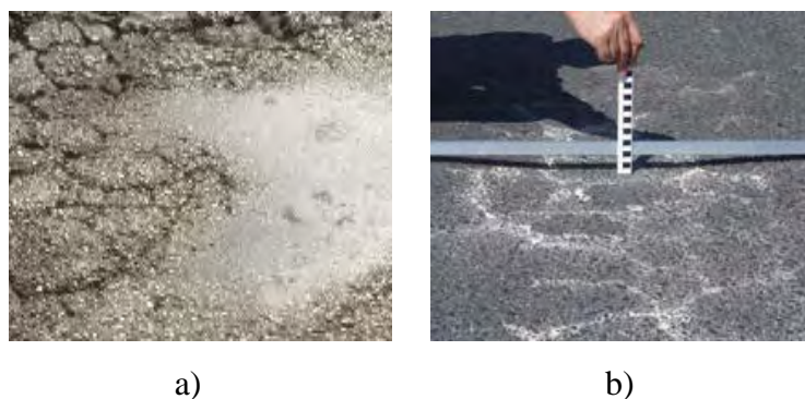
Figura 2.8 - a) Exsudação b) Subida de finos (Alves, 2007)
