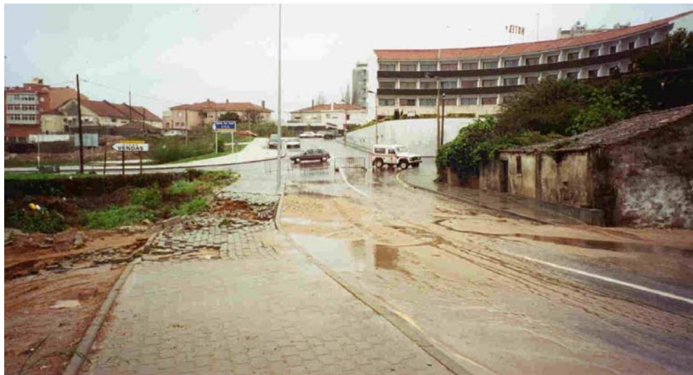
Exemplo de vias interrompidas por inundação: Ribeira da Graça, Ovar, Março de 2001.
