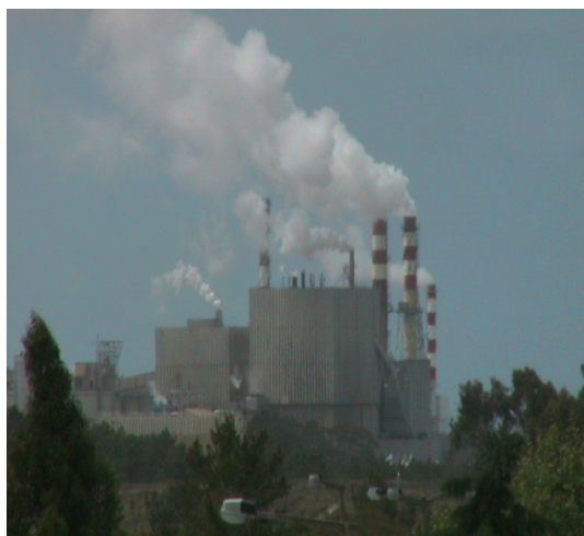
Figura 1.1. Aspecto de unidade industrial em laboração.
