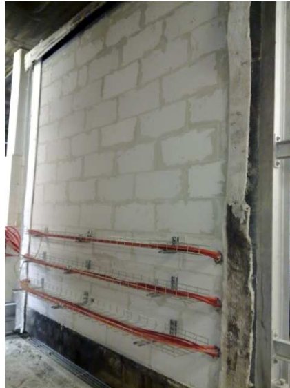
Figura 2-16 Parede em blocos de betão celular autoclavado Ytong(Ytong, 2010) .
