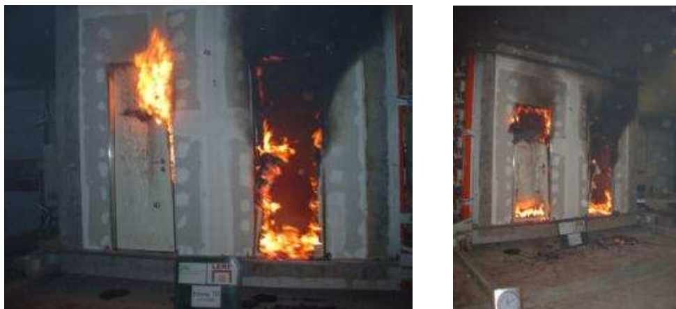
Figura 3-5 Destruição causada pelo fogo aos 10 minutos
