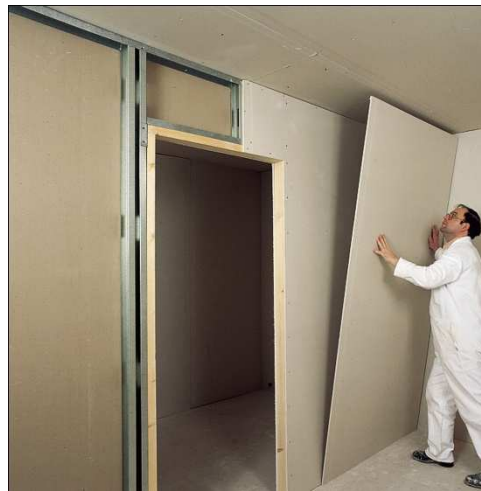
Figura 2-20 Colocação de placa de gesso cartonado(Viver, 2010).
