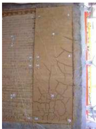
Figura 4-3 Face rebocada da parede não exposta ao fogo (Vila Real, et al. , 2009).
