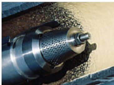
Figura 13. Pormenor do espigão utilizado na aplicação do revestimento epoxy [29]
