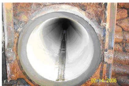
Figura 14. Resultado final da aplicação da técnica de sliplining numa tubagem [29]
