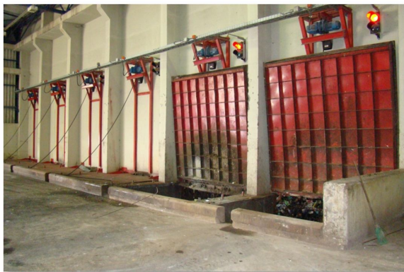
Figura 1.4 – Cais de descarga.
