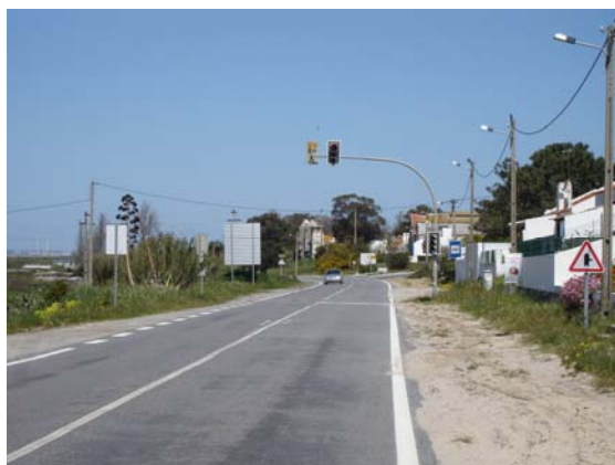
Figura 74 – Semáforos controladores de velocidade, Comporta (Grândola) – ER 253 – 1
