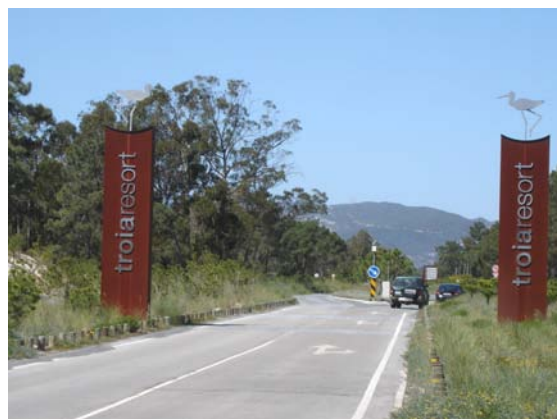
Figura 71 – Portão em Tróia (Grândola)
