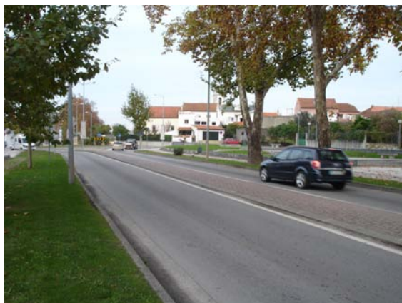
Figura 108 – Trecho de atravessamento, Mealhada
