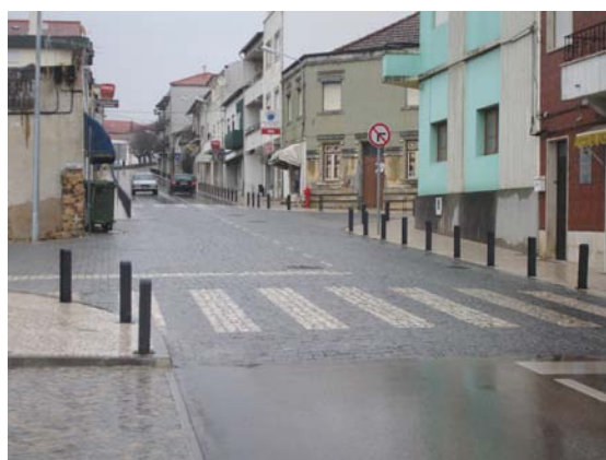
Figura 67 – Intersecção elevada, Condeixa-a-Nova
