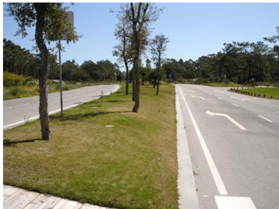
Figura 42 – Estrangulamento por separador central ( staggering ), Tróia (Grândola)
