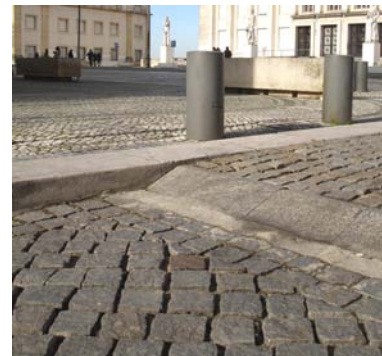
Figura 62 – Pormenor de lomba/perfil trapezoidal, Coimbra
