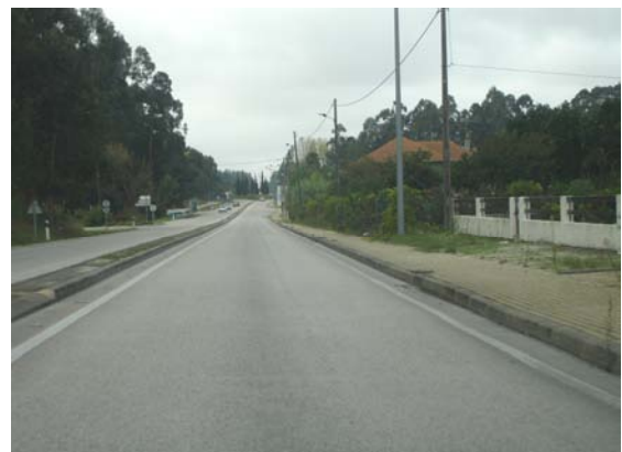
Figura 130 – Atravessamento de Fontinha (Cantanhede)
