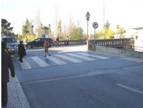
Figura 66 – Intersecção elevada, Tomar
