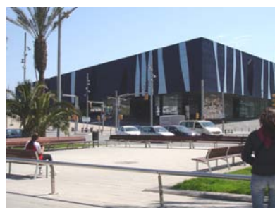
Figura 137 – Intervenções em espaços adjacentes a vias urbanas, Barcelona (Espanha)
