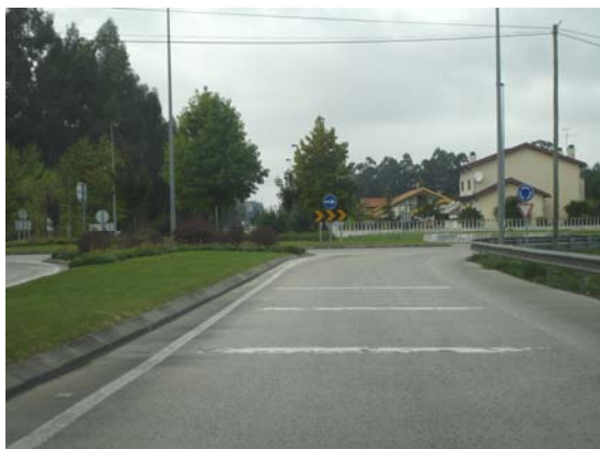
Figura 129 – Atravessamento de Fontinha (Cantanhede)
