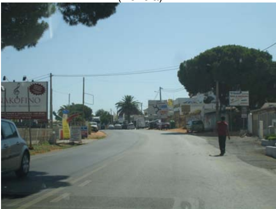
Figura 13 – Ausência de estrutura pedonal – EN 396
