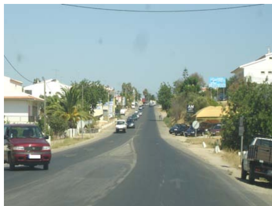
Figura 4 – Atravessamento de localidade – EN 125
