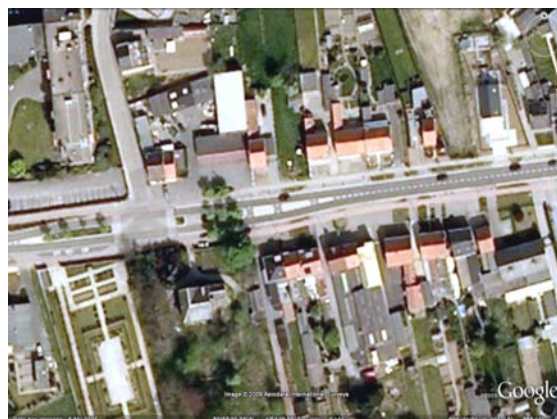
Figura 88 – Estrangulamento com ilhéu separador em Rillaar – 5.ª zona (Google Earth)
