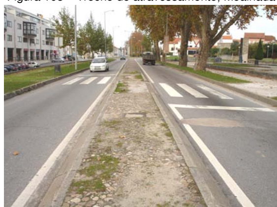
Figura 110 – Separador central elevado, Mealhada
