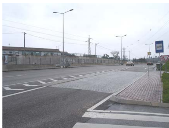
Figura 158 – Paragem de autocarros segregada da estrutura viária – EN 1 – IC2, Coimbra
