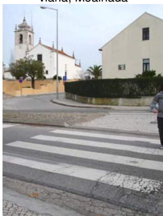
Figura 114 – Travessia pedonal em ilhéu separador, Mealhada
