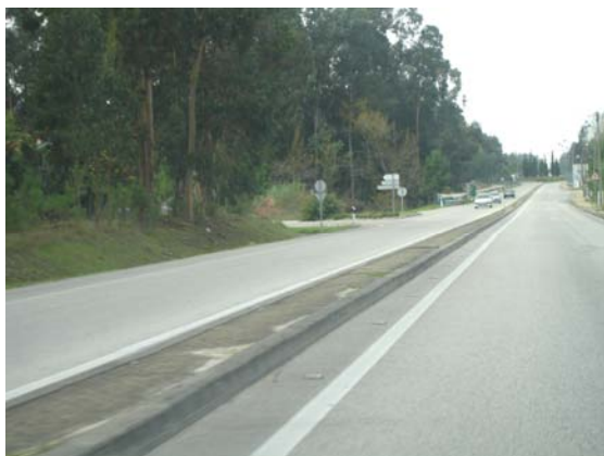
Figura 34 – Separador central – EN 234
