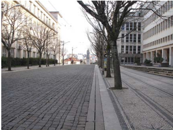
Figura 68 – Via ao nível do passeio, Coimbra
