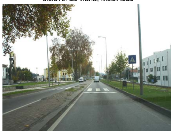
Figura 115 – Travessia pedonal enviesada à direita, Mealhada
