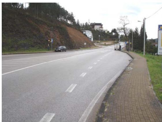
Figura 157 – Paragem de autocarros contígua à estrutura viária, Ceira (Coimbra) – EN 17
