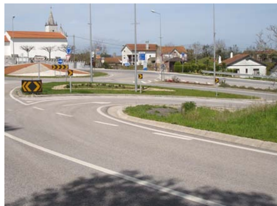
Figura 35 – Ilhéu separador direccional, Penela
