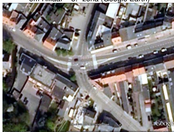
Figura 90 – Estrangulamento a partir do centro em Rillaar (Google Earth)
