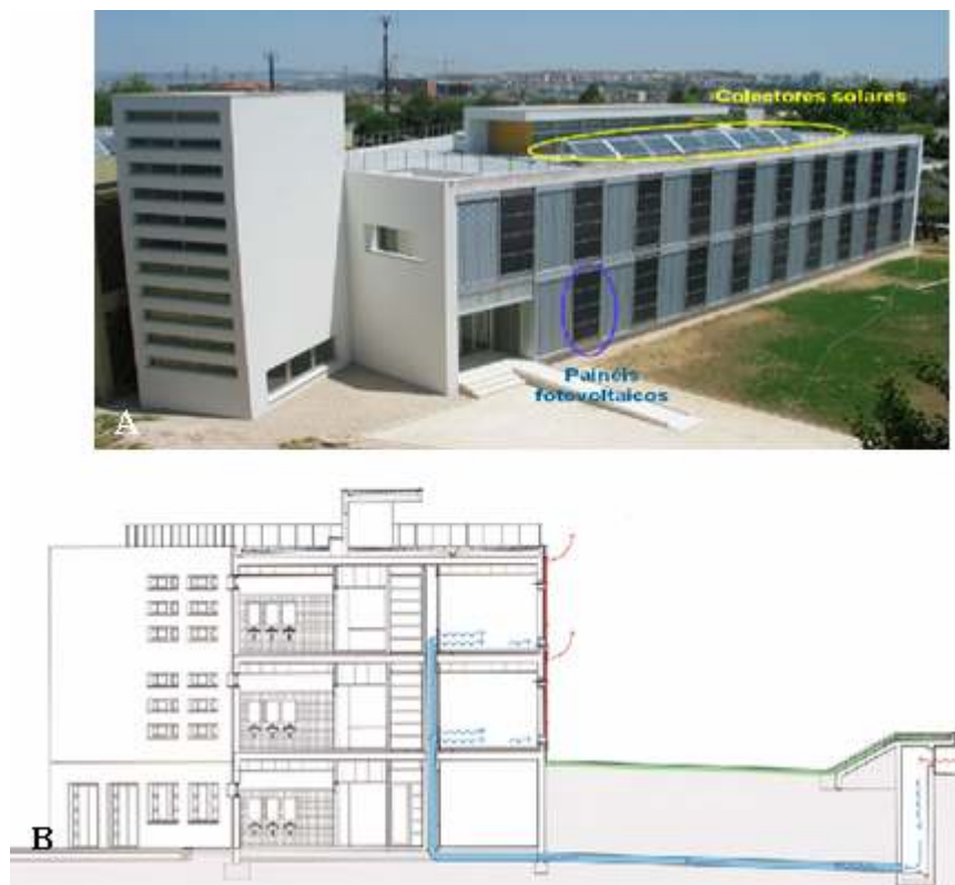
Figura 11 – Edifício Solar XXI: A) Pormenor do sistema solar (activo e passivo); B) Pormenor do sistema de arrefecimento passivo (retirado de [105a]).
