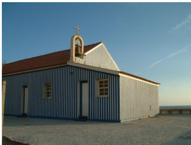
Figura 6.4 - Capela da Praia de Mira [W 5 ]
