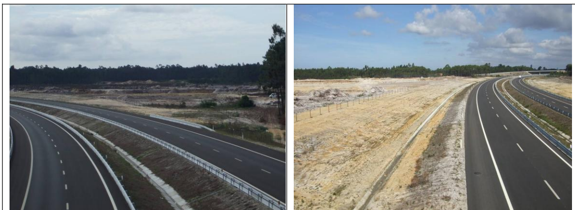
Figura 5.1 - Troço da auto-estrada A17 que passa pelo Concelho de Mira.
