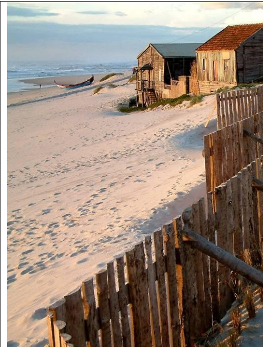
Figura 2.14 - Construção de ripados de madeira na base de uma duna primária (Fonte: Rico, 2008).
