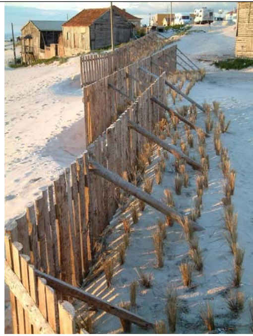
Figura 2.15 - Construção de ripados e plantação de vegetação na duna (Fonte: Rico, 2008).
