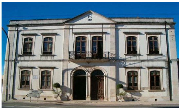
Figura 6.5 - Edifício Paços do Concelho [W 5 ]
