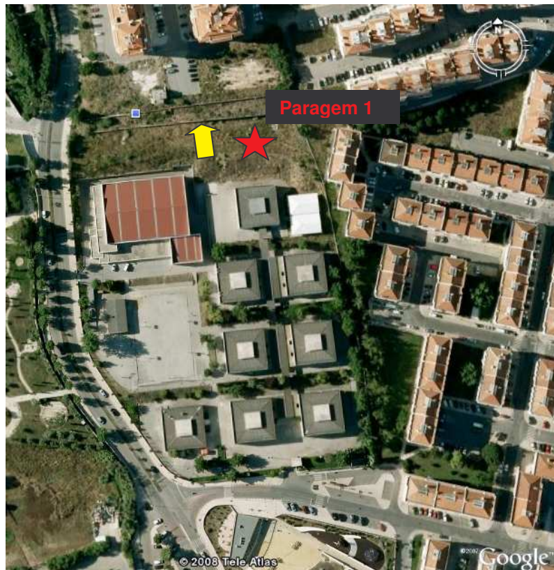
Figura III.5 – Fotografia de satélite mostrando a Escola Secundária Stuart Carvalhais. O talude Norte está assinalado pela estrela vermelha. A seta amarela assinala um muro construído para atenuar os problemas de erosão ( http://earth.google.com/gallery/ ).
