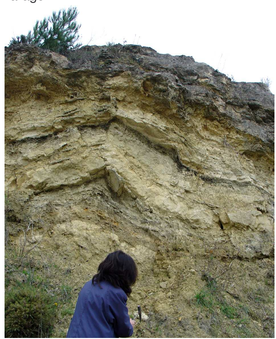
Est. VII-4: Dobra afectando as camadas da F. Caneças (Belasiano). Na zona de charneira identificam-se duas fracturas – Paragem 4.
