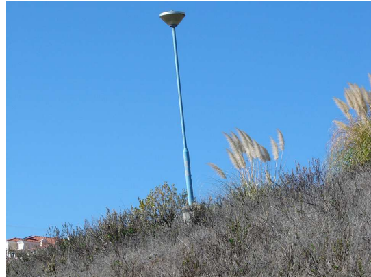
Est. I-2: Candeeiro inclinado por acção de movimentos de terreno – Paragem 1.
