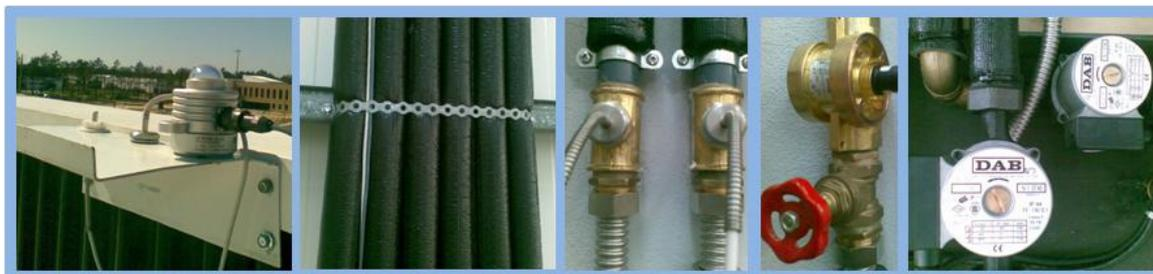
**Figura 24:** Fotografias dos componentes usados 2 (da esquerda para a direita: piranómetro, tubagens revestidas, sensores de temperatura, medidor de caudal, bombas eléctricas).
