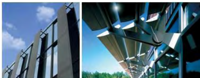
Figura 35 – Exemplos de sombreamento exterior: fixo [57] e móvel [58]
