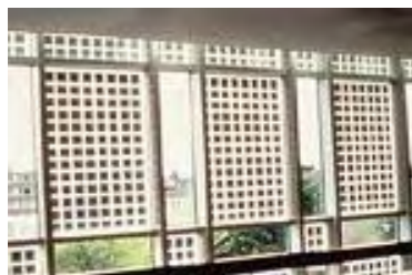
Figura 29 – Células fotovoltaicas integradas num vão envidraçado [46]
