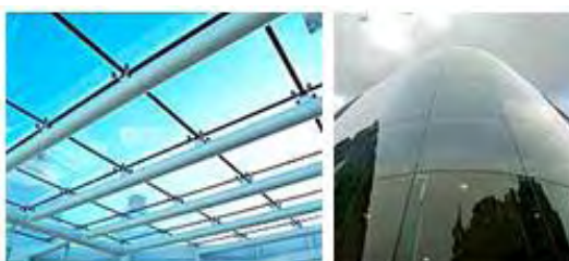
Figura 33 – Exemplos de fachadas em vidro exterior agrafado (VEA) [56]
