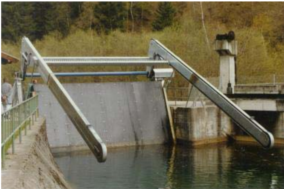
Figura 7 – Descolmatador de correntes de arrasto instalado na Central Hídrica de Gössnitz [2].
