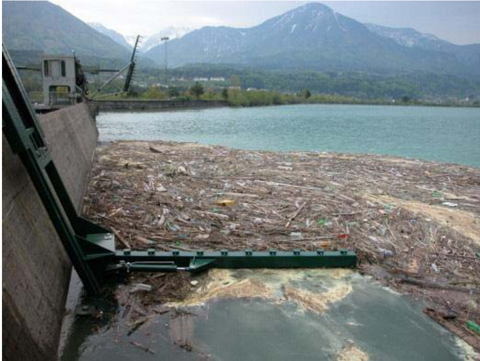
Figura 10 – Equipamento auxiliar do descolmatador móvel de accionamento por cabo instalado na Central Hídrica de Feistritz[2].
