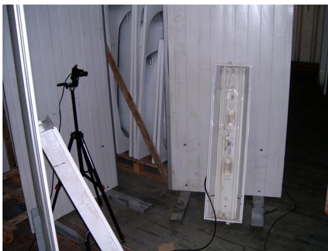
Fig. 29 - Montagem dos painéis laterais
