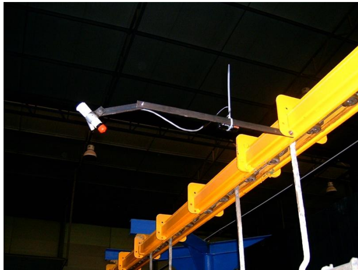
Fig. 30 - Montagem do suporte de fixação do laser
