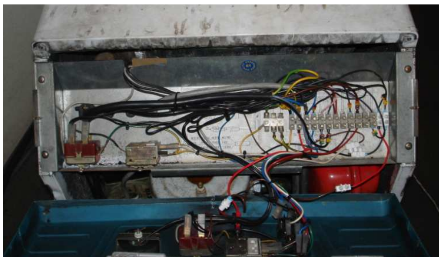
Figura 42. Circuito eléctrico da caldeira a gasóleo.
