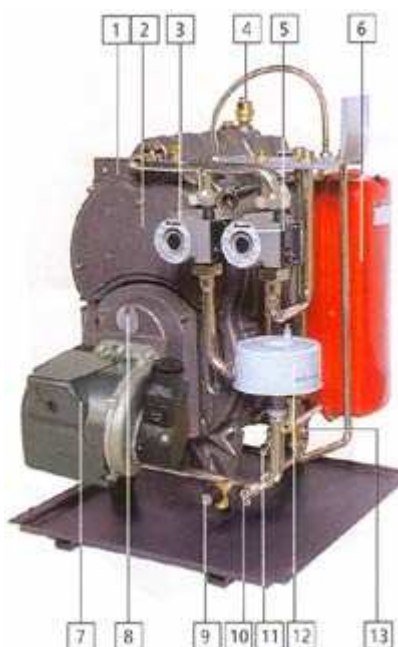
Figura 5. Caldeira a gásóleo em ferro fundido: 1-Corpo da caldeira de ferro fundido, 2-Registo de limpeza amplo, 3-Bomba de A.Q.S. de 3 velocidades, 4-Purgador automático, 5-Bomba da aquecimento de 3 velocidades, 6-Vaso de expansão de 12 litros, 7-Queimador pré-aquecimento, 8-Visor de chama, 9-Válvulas de segurança 3 bar. 10-Chave de esvaziamento, 11-Chave de enchimento, 12-Permutador tubular e 13-Fluxóstato. [4].
