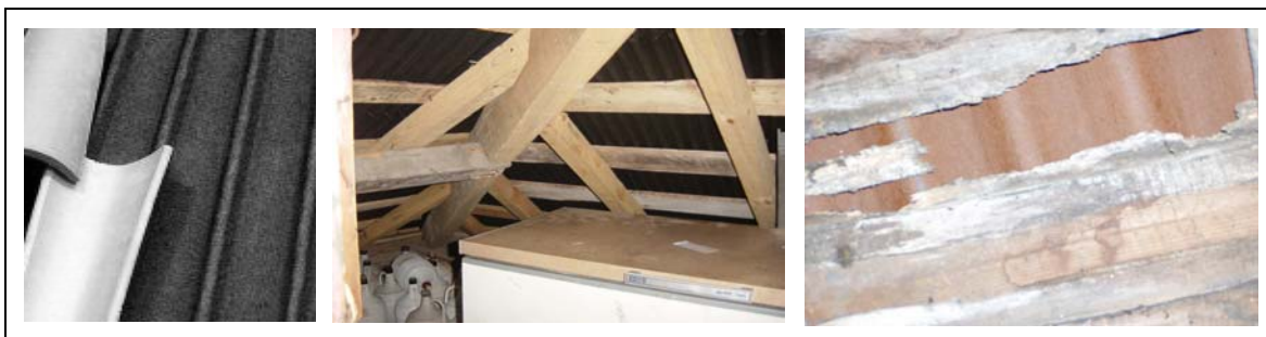
Figura 123: Uso de subtelha
