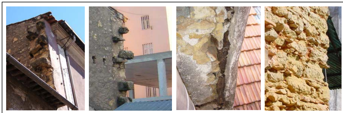
Figura 91: Cunhais e ligação entre paredes ortogonais
