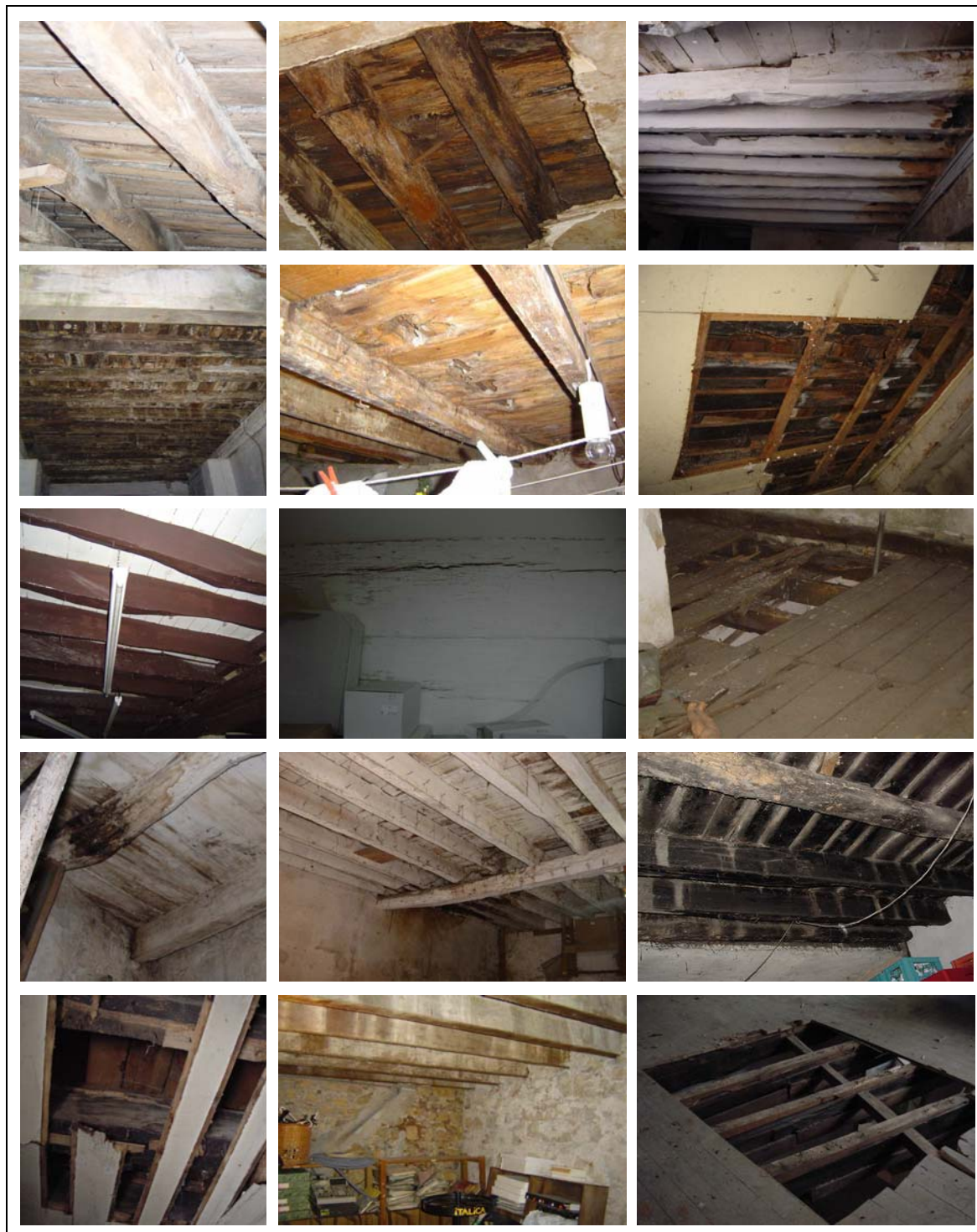
Figura 106: Pavimentos em madeira na Baixa de Coimbra
