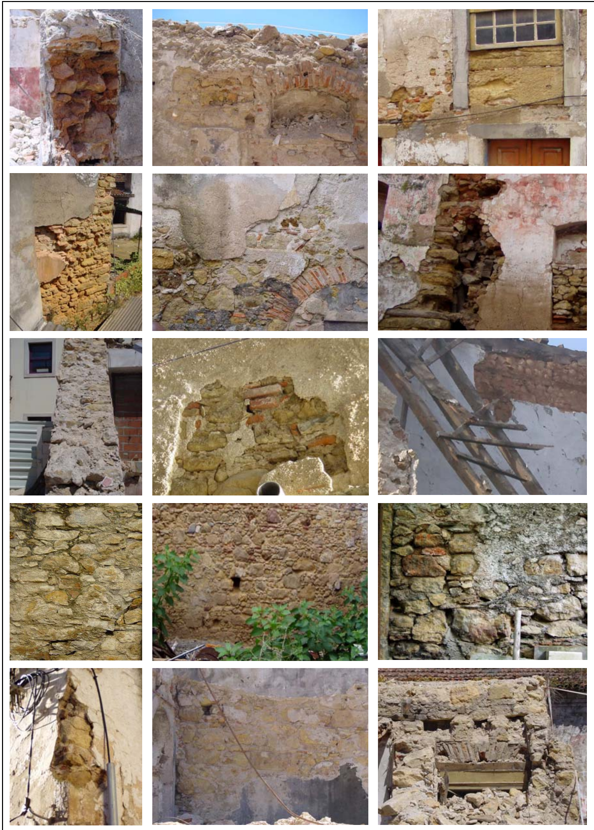
Figura 84: Alvenarias irregulares de pedra calcária na Baixa de Coimbra
