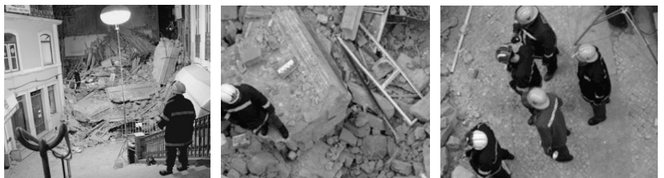
(queda de dois edifícios na Baixa de Coimbra, 01 de Dezembro de 2006) [Diário de Coimbra]
