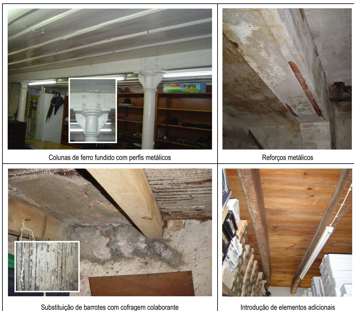
Figura 110: Reforço de pavimentos de madeira
