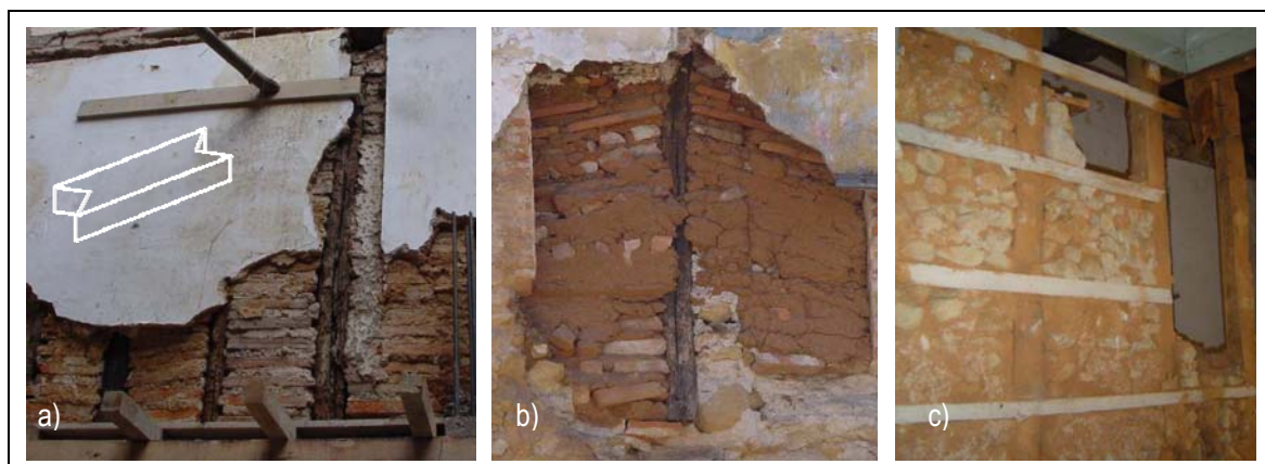
Figura 88: Alvenaria com prumos de madeira distanciados cerca de 60cm na vertical em paredes meieras
