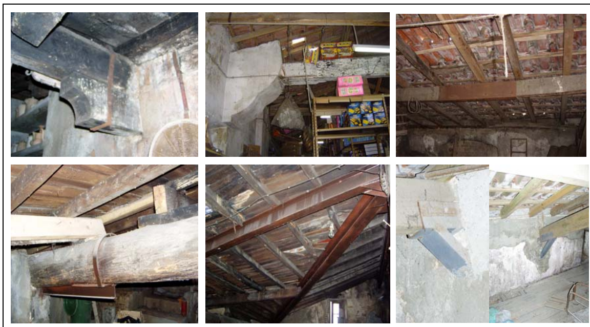
Figura 124: Exemplos de sistemas de reforço observados na Baixa de Coimbra
