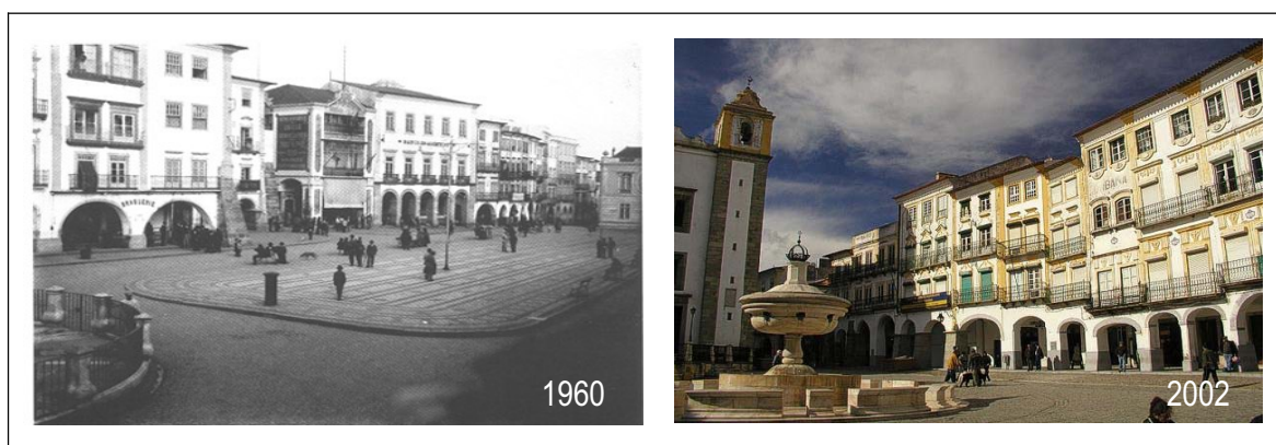
Figura 10: Manutenção e recuperação do edificado [CME, 2007]
