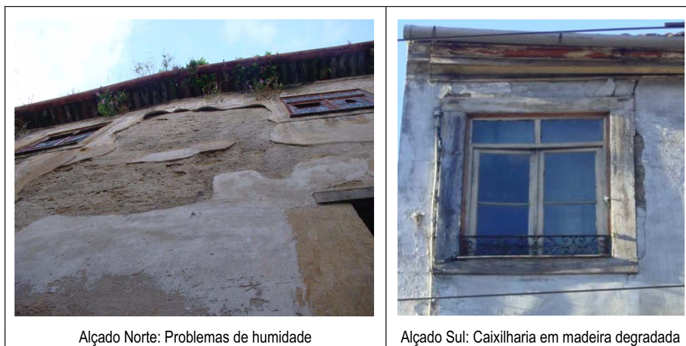
Figura 23: Problemas resultantes da acção climática
