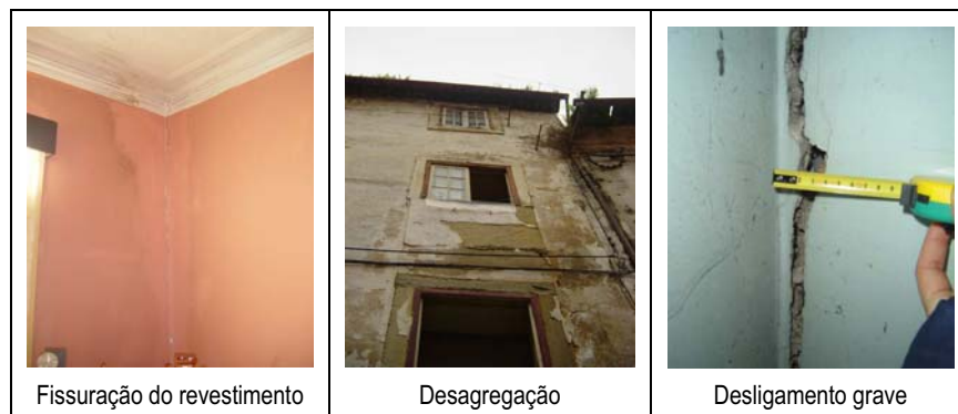
Figura C35: Danos a observar em paredes de fachada
