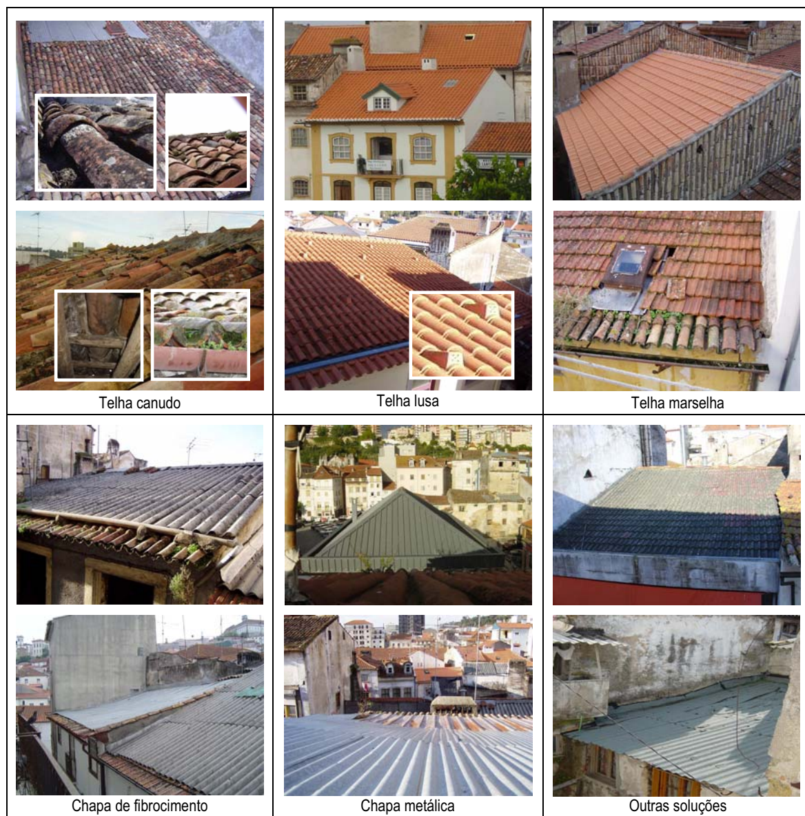
Figura 122: Exemplos de soluções de revestimentos de coberturas inclinadas na Baixa de Coimbra
