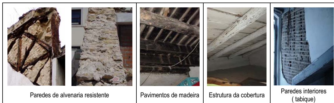
Figura 247: Detalhes construtivos dos edifícios antigos
