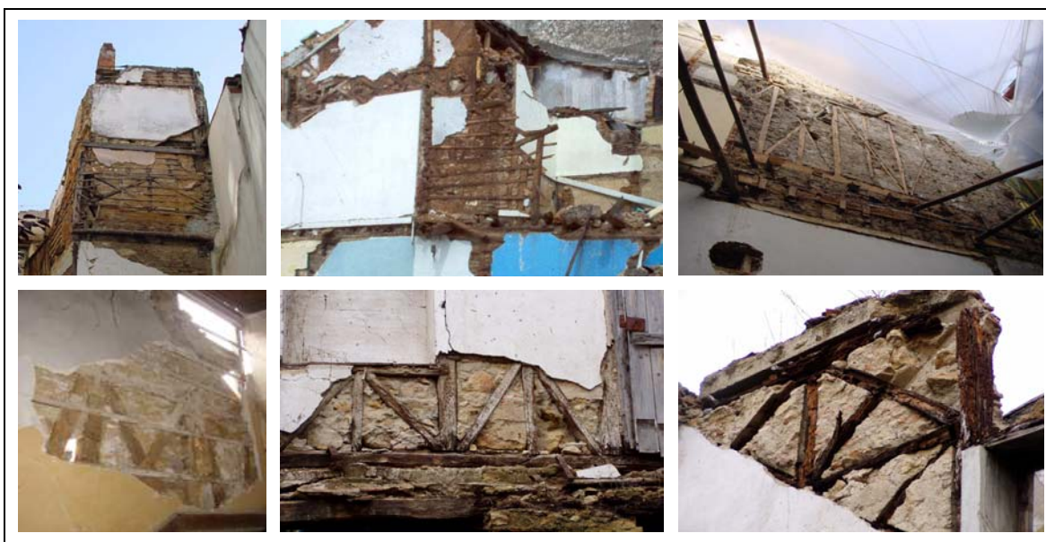
Figura 87: Paredes de alvenaria com estrutura de madeira
