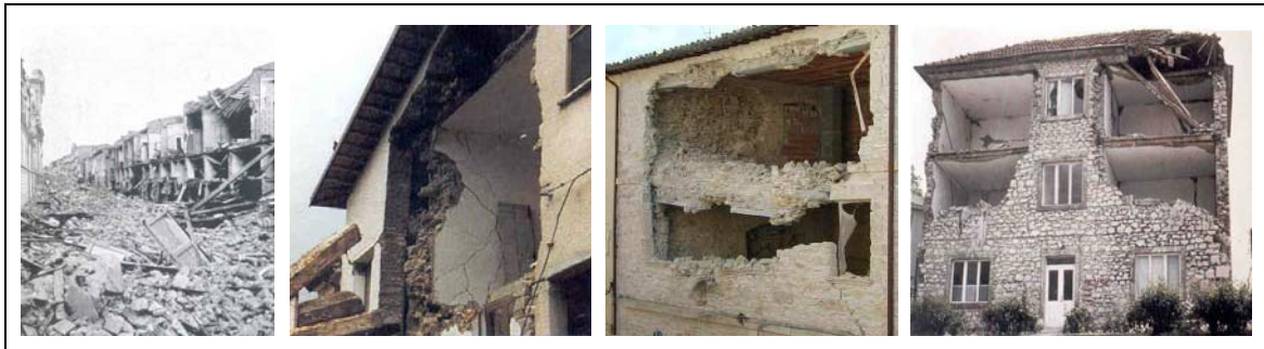
Figura C29: Exemplos de colapsos das paredes para fora do plano [Ortigia, 2000; NISEE, 2006]
