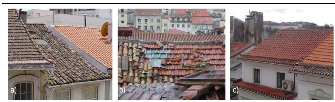
Figura 121: Revestimentos de coberturas inclinadas: a) Cobertura em telha tipo canudo com assentamento do tipo “valladio”; b) Heterogeneidade de soluções; c) Coberturas com cuidados exclusivos na zona corrente
