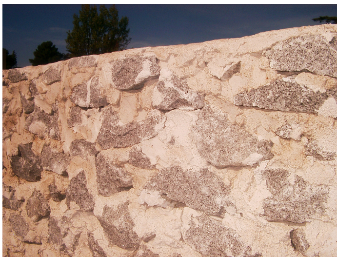
Fig. 6.92 Aplicação de argamassa de junta em parede de granito
