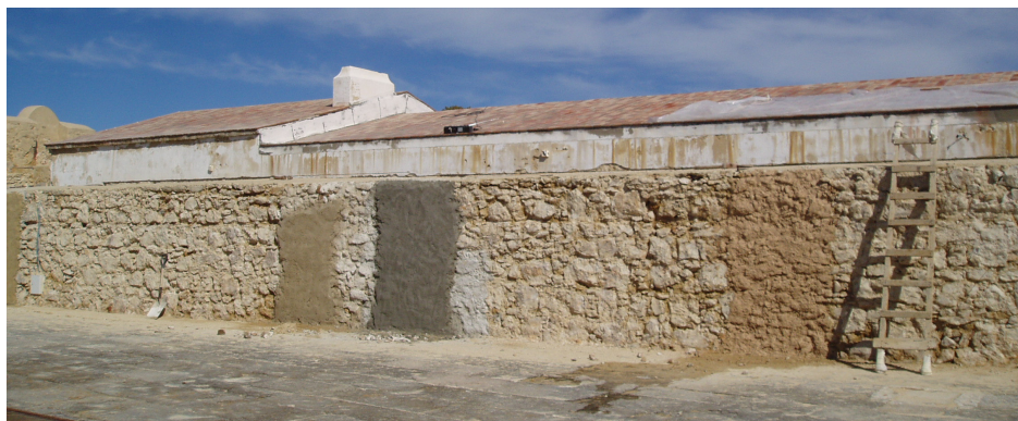
Fig. 6.95 Parede com painéis 3 e 4 e salpico para execução do painel 5
