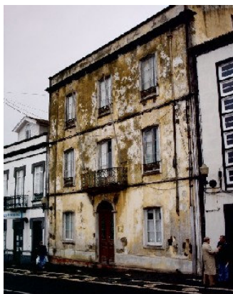
Fig. 5. 1 Casa Rua Eng.º José Cordeiro, 93 Ponta Delgada
