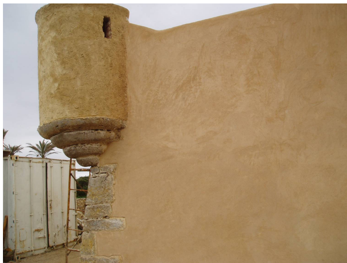
Fig. 6.96 Parede rebocada com argamassa de cal aérea e metacaulino
