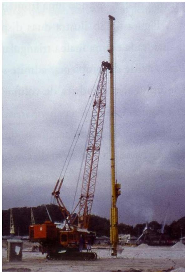
Figura 26 - Equipamento que instala os drenos sintéticos [Fernandes (2006)].
