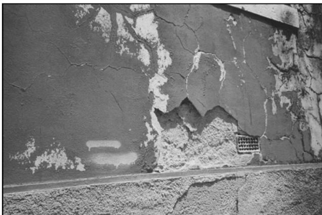
Figura 2 - Reboco com falta de adesão entre camadas [4,5,6]
