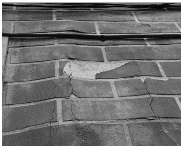
Figura 4 - Revestimento com abaulamento do suporte, fissuras e destacamento da pintura [4,5,6]
