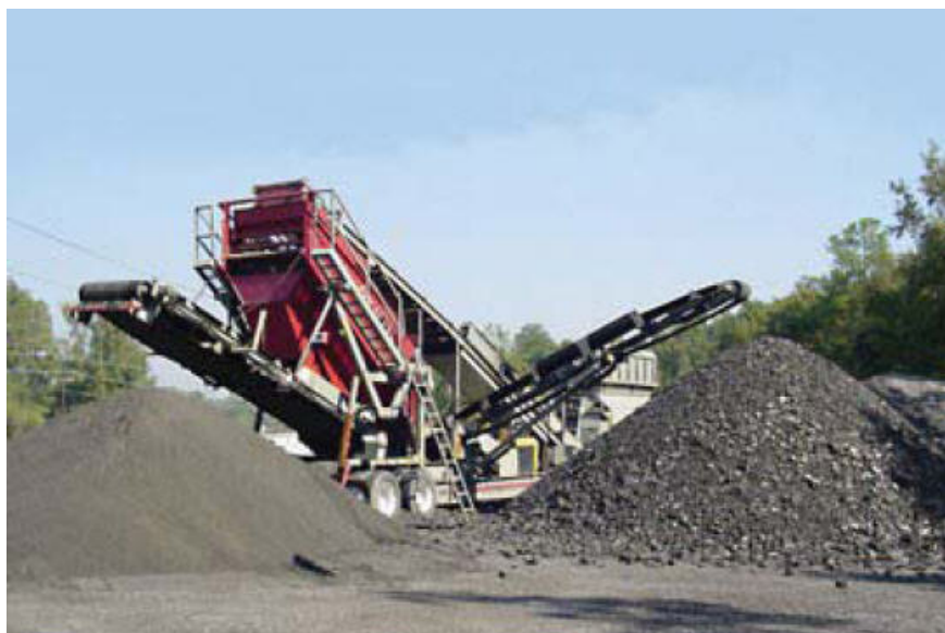
Figura 3-20. Estaleiro para agregados das misturas betuminosas. (Caltrans, 2005)
