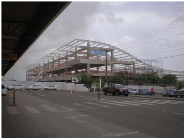
Figura 49: Novo terminal de Macapá sendo construído
