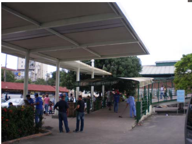
Figura 75: Calçada externa do terminal do Porto de Manaus
