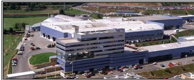
Figura 26 - Instalações da Toyota Caetano Portugal em Gaia
