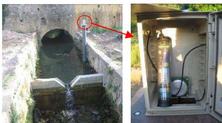
Figura 5 – Limnígrafo utilizado para monitorização da altura de água na ribeira dos Covões.
