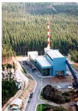
Figura 4 - Central termoeléctrica de biomassa de Mortágua
