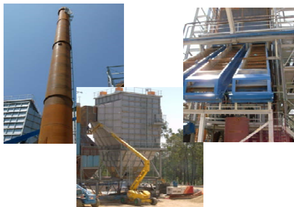
Figura 9 - Central Termoelétrica de Biomassa de Terras de Santa Maria (em construção)
