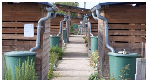
Figure 6 : Perspective sur les récupérateurs d'eaux de pluie des jardins familiaux au sein de l'écoquartier Saint-Jean-des-Jardins à Chalon-sur-Saône [CAUE du Loire et Cher 2009].
