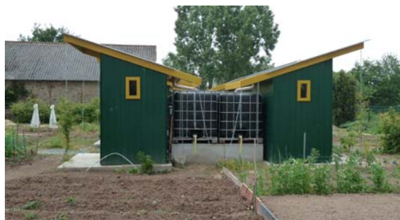
Figure 7 : Récupérateurs d'eau de pluie de toitures, maximisés, dans un jardin collectif à proximité de l'écoquartier des Perrières à la Chapelle-sur-Erdre, près de Nantes (Ph. N. Le Nouveau / Certu).
