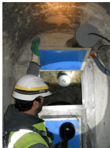
Figure 10 - Caméra vidéo installée à l'amont du Déomatic ®
