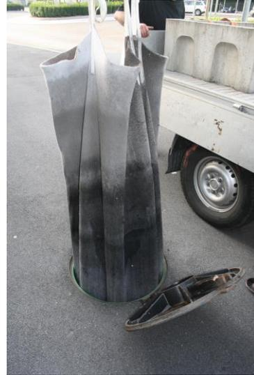
Figure 3 : sac en géotextile retiré de la chambre de visite après utilisation.
