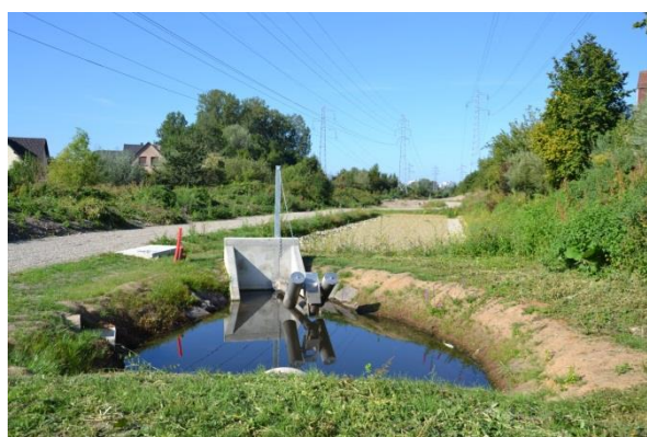
Figure 7. Ensemble de la filière de traitement des effluents provenant du bassin versant n°2 (le 7/09/12)
