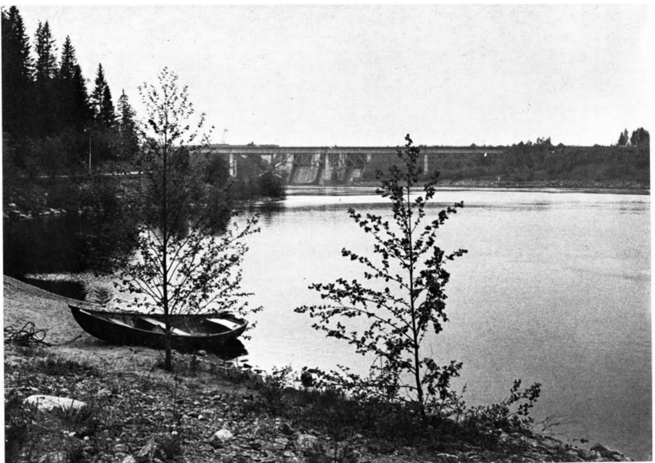
Barrage près de Sundsvall (Suède) photo R. Bechmann - Doc. A & N
