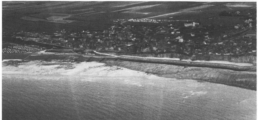
Vue d'ensemble de la falaise d'Ault (Doc. Fondation nationale pour la prévention des risques naturels).
