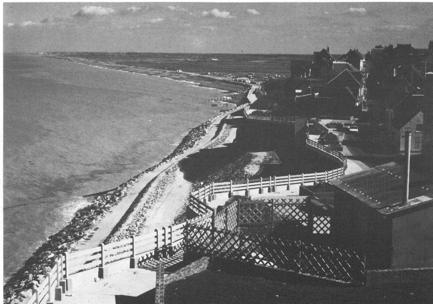
La falaise d'Ault, après les travaux (Doc. Fondation nationale pour la prévention des risques naturels).
