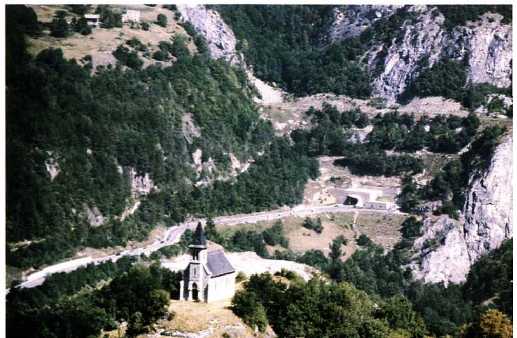
Site du Tunnel du Siaix - (Doc. DDE) - Photo Guy CHABERTY.
