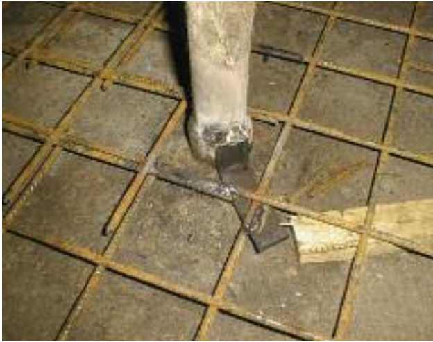
Figure 3 : La réfection de la dalle avec mise en équipotentialité parfaite est une méthode très efficace en cas de troubles du comportement dans la stabulation (cliché F. Gallouin).
