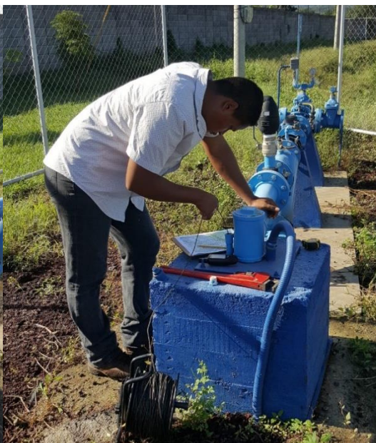
Foto 4. Realización de prueba de bombeo
