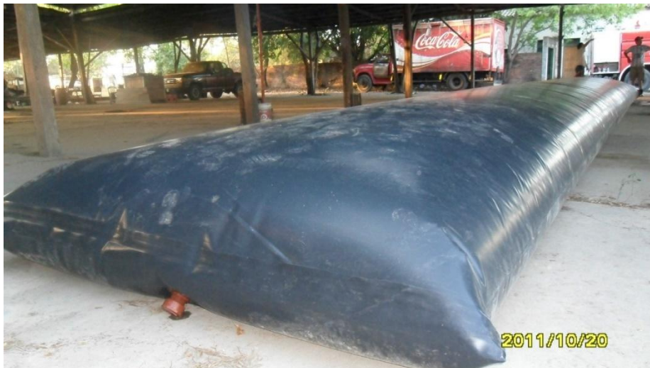
Figura 10: Geotanque (reservorio de agua)
