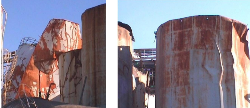
Fig 1 : Flexion et flambage de réservoirs (AZF 2001, documentation INERIS)
